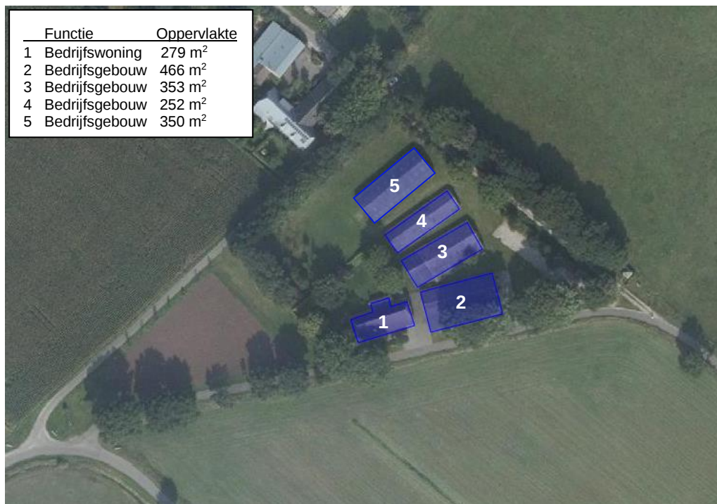
Figuur 3. Huidige situatie bebouwing plangebied.
