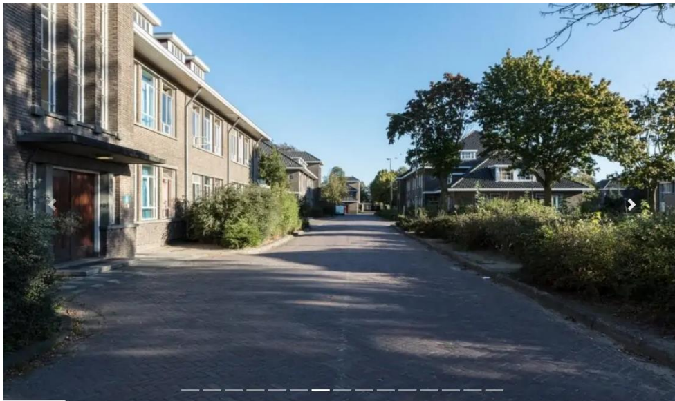
Gebouw G, E1 en E2: voormalige legeringsgebouwen (bron: BOEi.nl)
