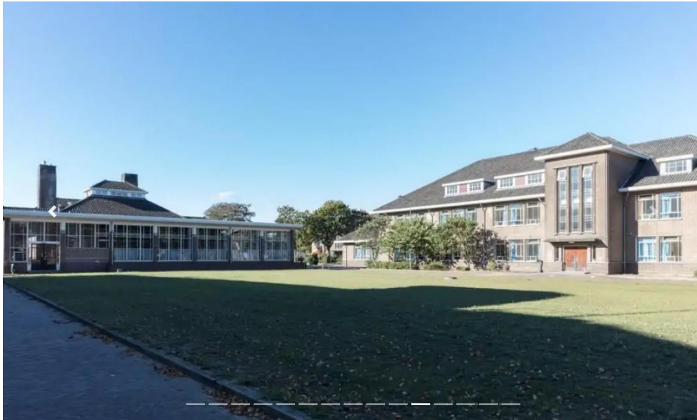
Gebouw H en E1: voormalig kantinegebouw en legeringsgebouw, op de voorgrond de appèlplaats (bron: BOEi.nl)
