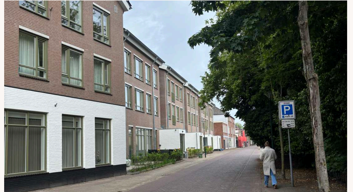
Getransformeerde bibliotheek aan de Kaneelstraat
