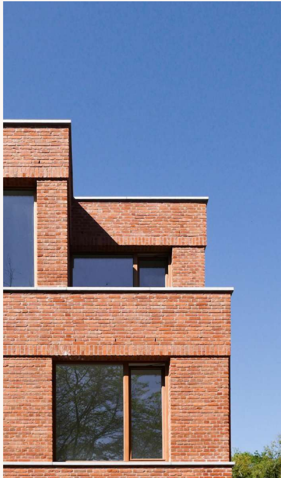
Horizontale geleding door uitstekende rollagen met een betonnen afdekker bij de dakranden
