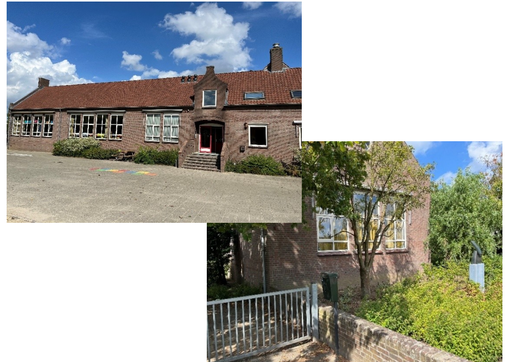
Enkele beelden van het exterieur. Goed onderhouden exterieur. Gevelopeningen zijn grotendeels vervangen met dubbelglas in aluminium kozijnen en dakramen.
