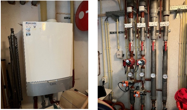
De nieuwe HR-ketels en het geïsoleerde leidingwerk.
