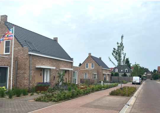
Doorlopende kopgevel, uitgetimmerde bakgoot
