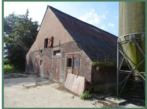
Overzicht aangebouwde schuur vanaf oost
