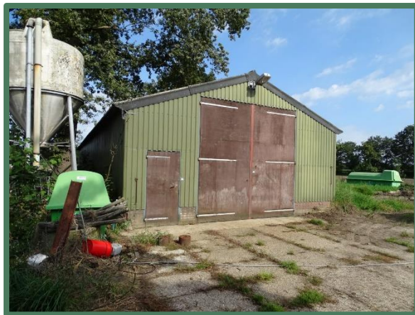
Overzicht te behouden damwand loods
