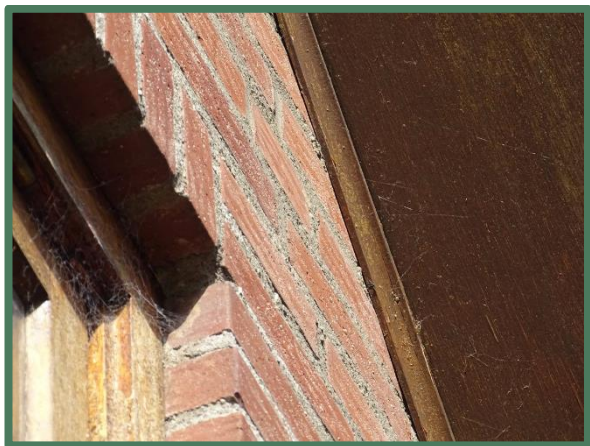
Strak aansluitende overstekbetimmering
