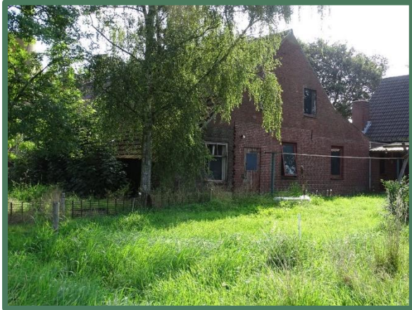
Achterzijde aangebouwde schuur vanaf west
