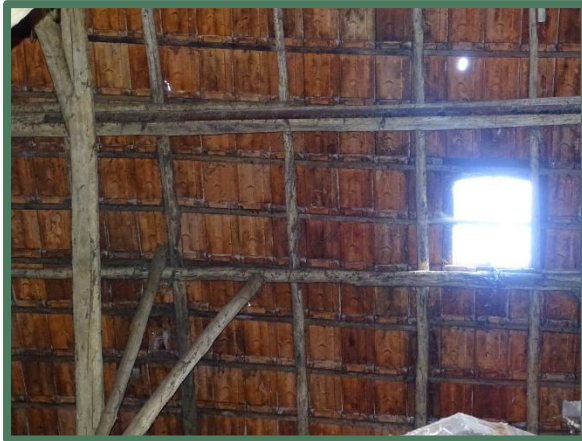
Onderaanzicht dak oude schuur
