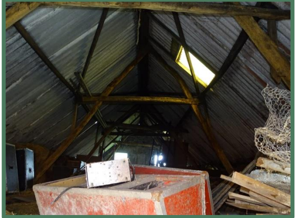
Binnenzijde aangebouwde schuur
