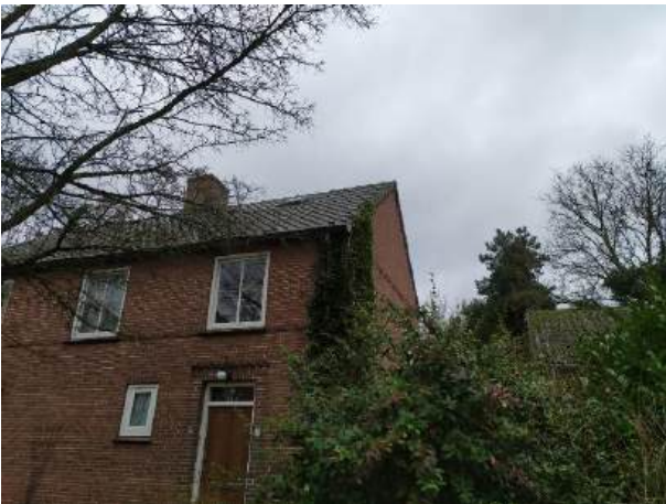
Figuur 7 dak van het gebouw met huisnummer 1.
