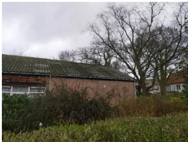
Figuur 6 dak van het gebouw met huisnummer 3.
