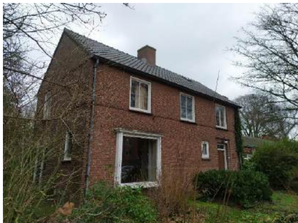
Figuur 5 dak van het gebouw met huisnummer 1.
