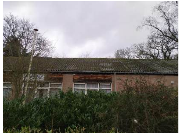
Figuur 8 dak van het gebouw met huisnummer 3.
