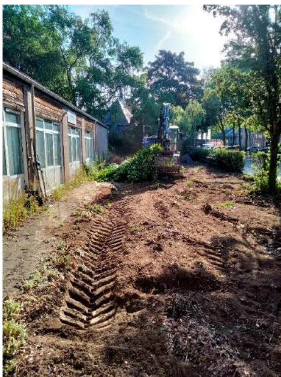
Afb. 1.3. Voorbereidende werkzaamheden aan de Marktzijde van het plangebied.
