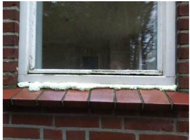
Figuur 10 purschuim vult ruimte tussen kozijn en buitenmuur op.
