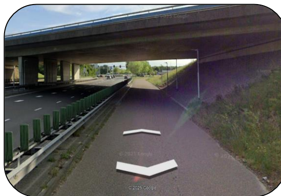
Figuur 23: Onder viaduct in de A73
