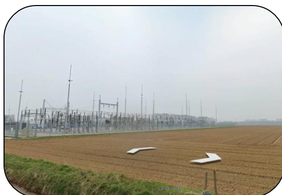
Figuur 29: Toegangsweg naar bouwterrein
