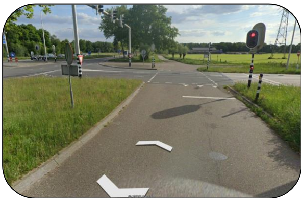
Figuur 24: Smalle oversteek afrit A73
